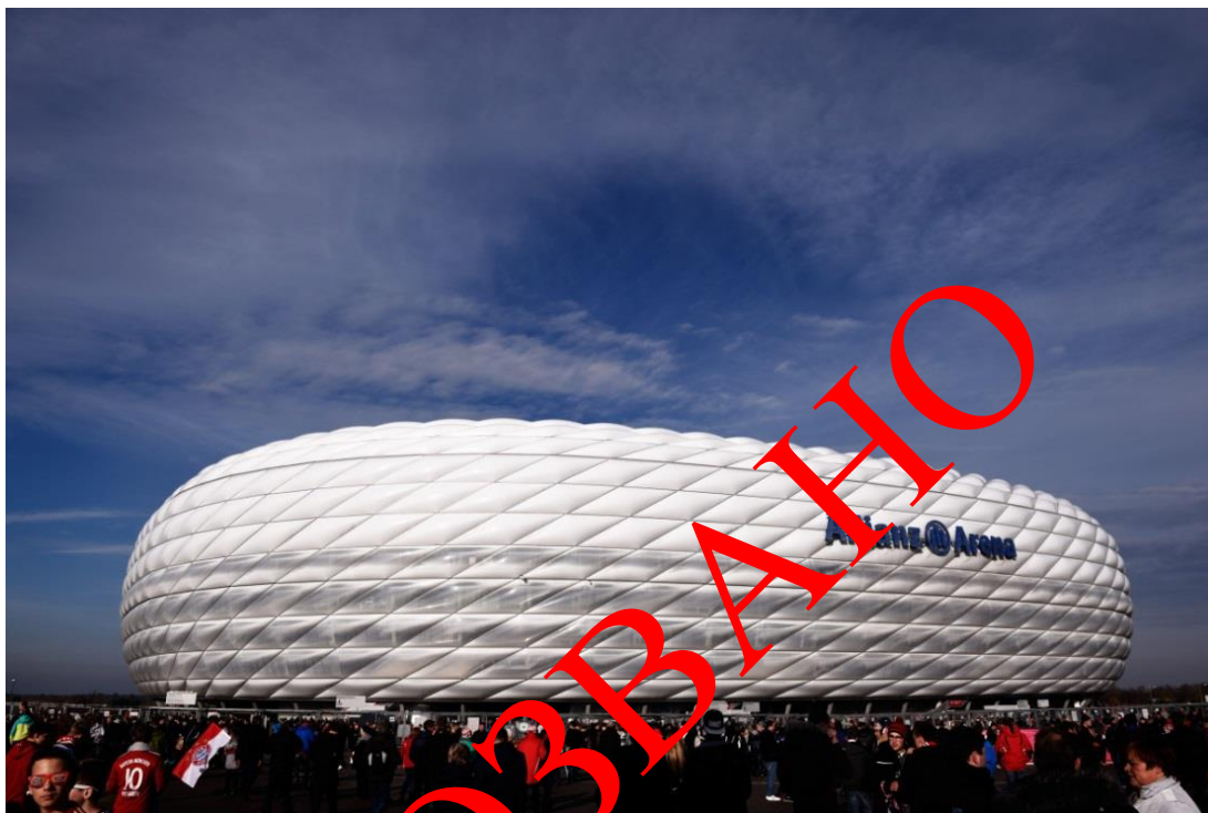
Рис. 1. Фасад стадиона Allianz Arena из полимерной ETFE-пленки. Архитектурное бюро Herzog & de Meuron Architekten. 2005 г. Германия, г. Мюнхен.
