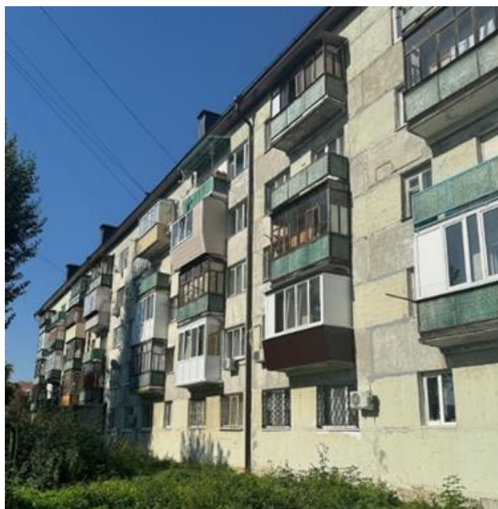
Рис. 1. Многоквартирный жилой дом, расположенный по адресу г. Тюмень, ул. Флотская, 15
