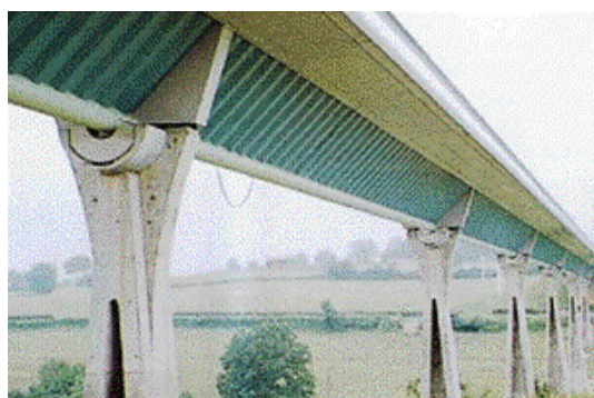
Рис. 2. Применение балок с гофрированной стенкой в мостостроении
