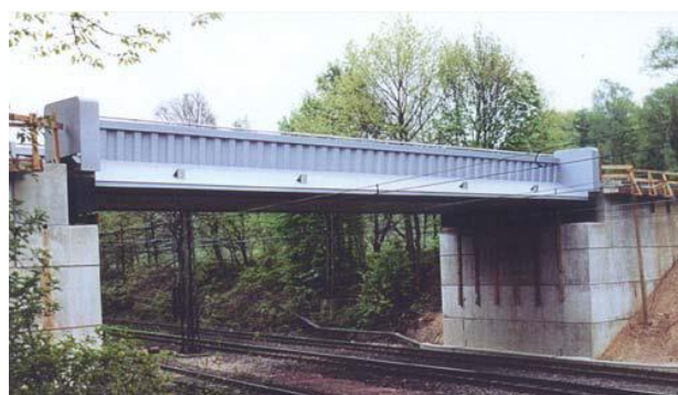
Рис. 2. Применение балок с гофрированной стенкой в мостостроении
