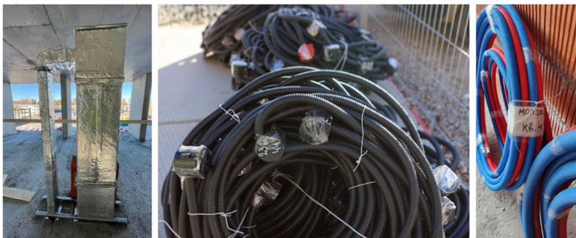
Рис. 4. Инженерные сети, собранные в условиях цеха (фото Давыдова Н.С.)
