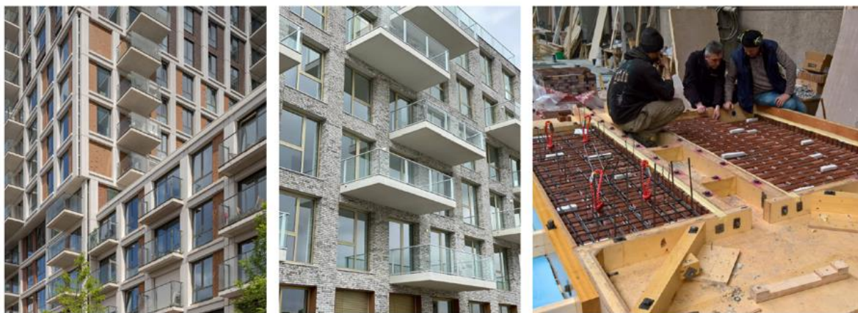
Рис. 1. Примеры использования модульного строительства в Европе (фото Давыдова Н.С.)
