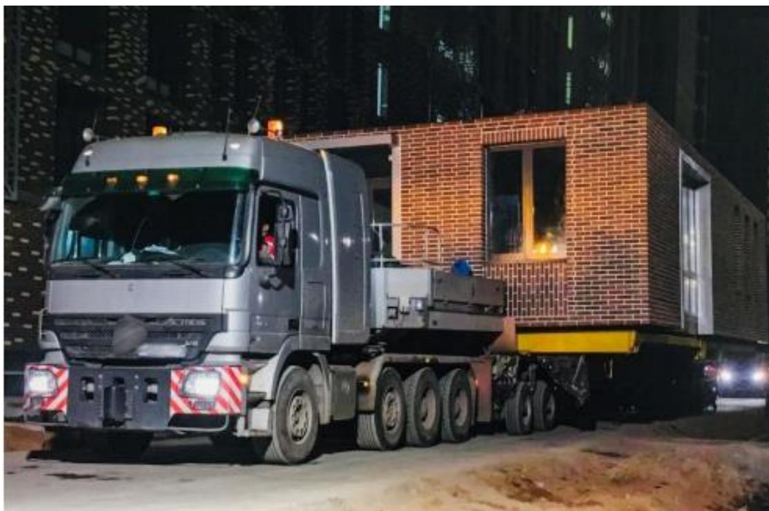
**Рис. 2.** Пример транспортирования модуля
