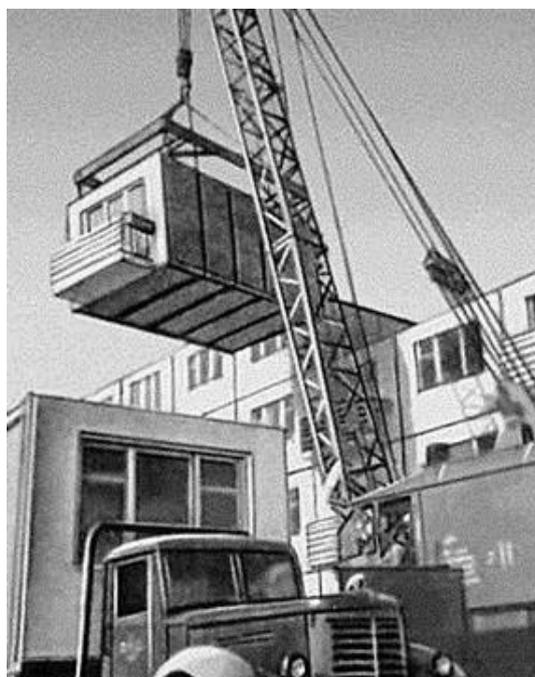
**Рис. 5.** Монтаж блок-комнаты
